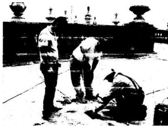
Sacando una prueba de la Azotea del Torreón para ver daños originados por la lluvia.
